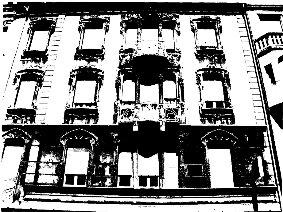
Maison Art Nouveau, N°4, rue de l'Alzette
